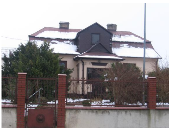
Budynek zabytkowej plebanii kościoła parafialnego w Przytyku
