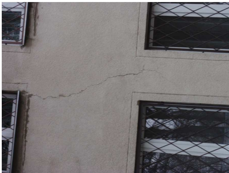
Zarysowany filar ściany nośnej budynku.
