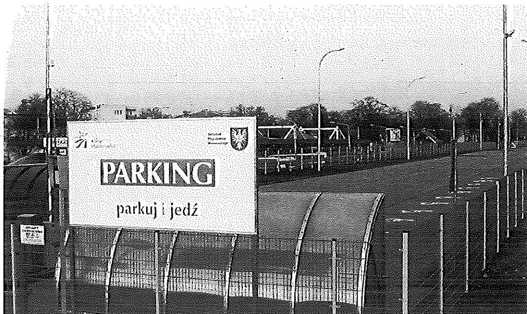
Rys. 7.3 Parking P+R Radom Główny.
